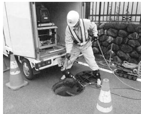
マンホールから調査用カメラを投入する作業
