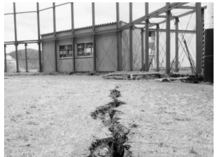
▲町営運動場。亀裂が走りバックネットが浮いている
