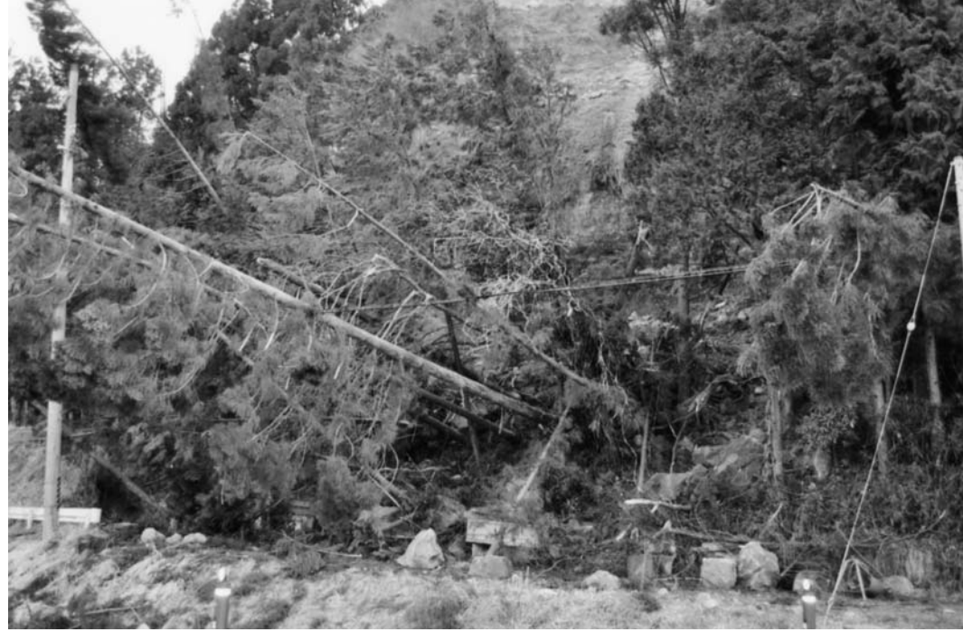
町道西河内・堀越線の土砂崩れ
