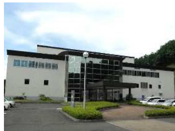
西白河地方リサイクルプラザ
