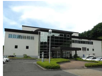
西白河地方リサイクルプラザ
