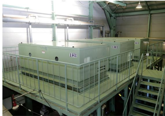
高速遠心脱水機の遠心効果と内胴スクリューと外胴部の回転差速の制御により汚泥の脱水分離処理を効率的に行います。脱水処理に最適な無機凝集剤（ポリ硫酸第二鉄）と凝集助剤（高分子凝集剤）の2種類の薬品を注入することで、脱水汚泥の低含水率化を図っています。
