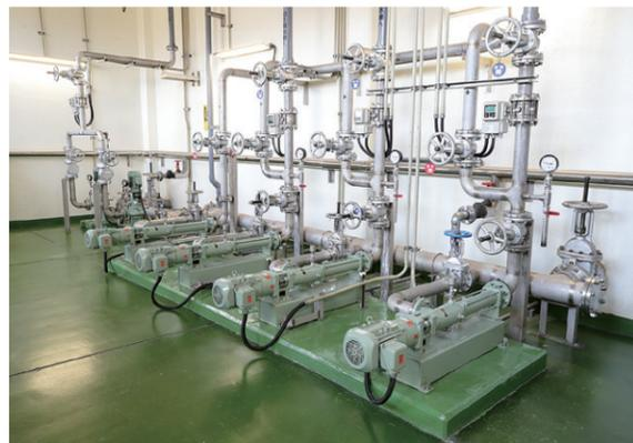
汚泥脱水機の安定的な運転を行うため、汚泥を定量供給します。
