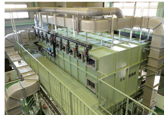
充填材に石炭系粒状担体を用いて、そこに繁殖させた微生物の働きにより、臭気成分（硫化水素、アンモニア、メチルメルカプタン、硫化メチル、二硫化メチル等）を分解処理します。薬品を使用しない最先端システムで環境に配慮しています。
