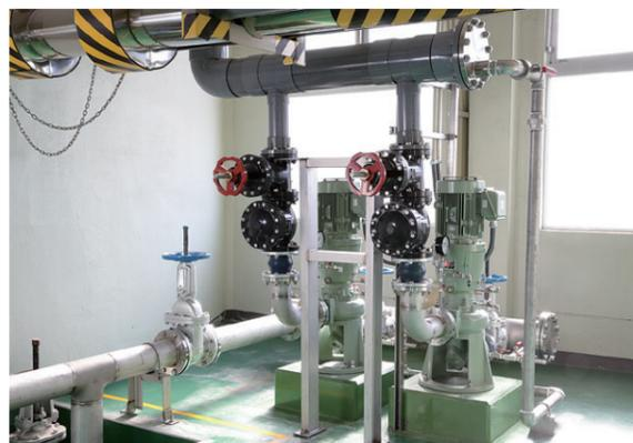
脱水ろ液槽内を攪拌して均一化し、脱水ろ液の性状を安定化します。
