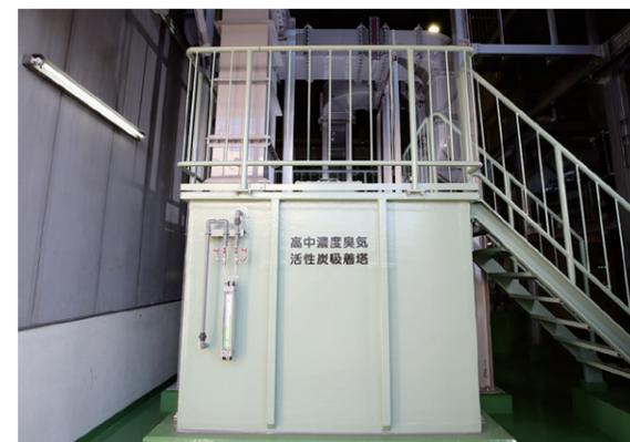
生物脱臭装置の処理後に活性炭の有する強力な吸着力を利用し、残留する臭気成分を除去します。種類を問わず、微量・微細な臭気成分まで除去できるため、万全な臭気対策を図ることができます。
