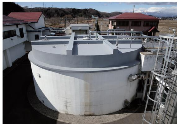
脱水ろ液を5日以上貯留できる有効容量（540m<sup>3</sup>）を有し、休日期間の主処理設備の安定的な運転に対応しています。
