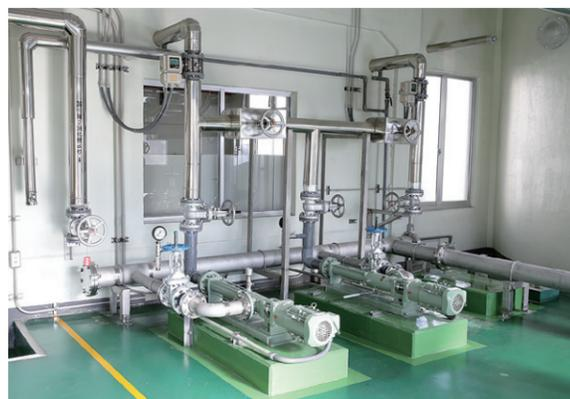
汚泥脱水機で固液分離された脱水ろ液を脱窒素槽へ定量投入して、主処理設備の安定的な運転を行います。
