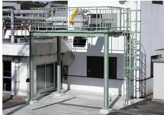
密閉されたケース構造のフライトコンベヤでし渣を場外搬出用車両の荷台に一定量ずつ連続搬送します。
