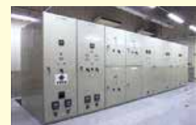
電気室 電力の受電・変電・配電を集中制御しています。
