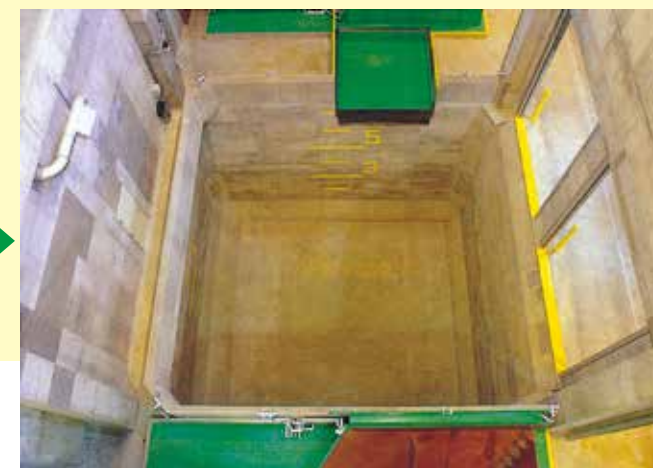
貯留ピット ごみはピットに貯留されます。
