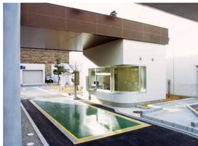
ごみ計量機 搬入されたごみを自動計量・記録します。
