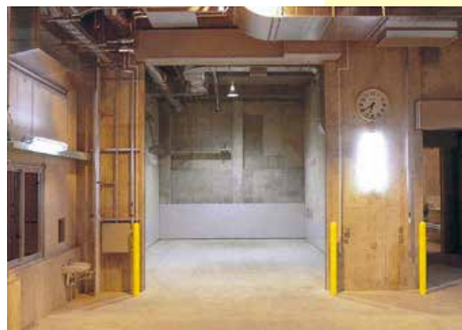
貯留ヤード 搬入されたごみを一時貯留します。
